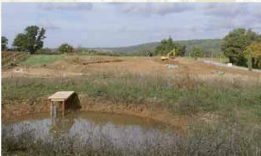
Die kleineren Sammelbecken haben sich im regnerischen Sommer 2018 bereits gefüllt. Im Hintergrund ist der Aushub für den sechsten, den grossen Retentionsteich, in vollem Gange. Die Teichböden werden nicht mit Folien oder Beton versiegelt, sondern durch präzise Aufschichtung von Feinerde und Lehm abgedichtet.
